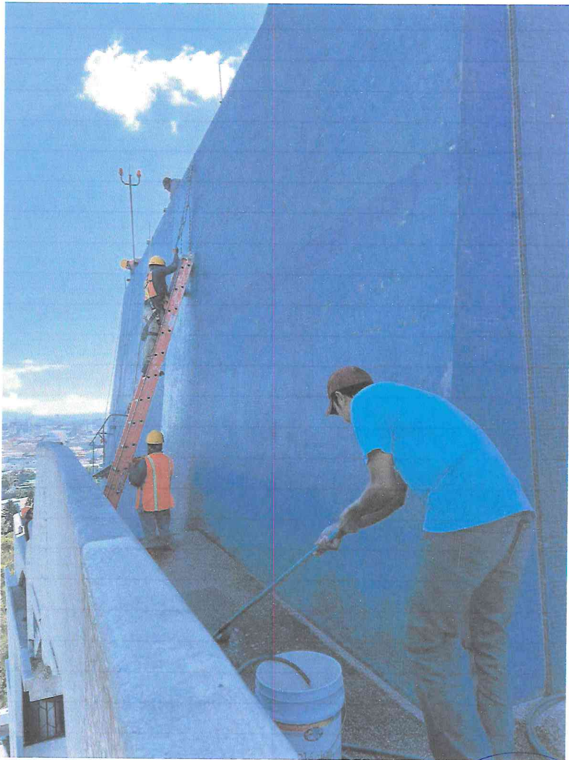
Trabajos de limpieza y desinfección en teselas y piso de granito, en segmento A1 de fachada oriente.
